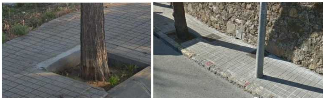
Fig. 9. Elements reductors de l'amplada útil. Font: Elaboració pròpia
